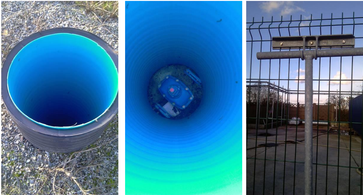
Figure 45: Photographies- vanne de fermeture générale du réseau – Vanne VG1
