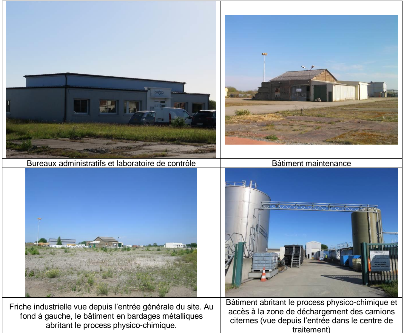
Figure 57: Prises de vue photographique sur le site des bâtiments existants
