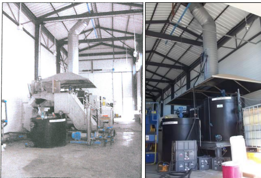
Figure 51: Unité de traitement physico chimique à l'intérieur du bâtiment, avec hotte d'aspiration au-dessus des cuves de traitement
