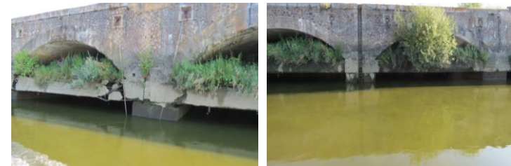
Succession de voûte avec végétation implantée sur les poutres
