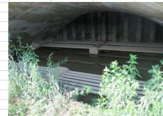
Voute restaurée à l'aide de tirant-métallique
