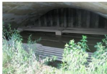
Voute restaurée à l'aide de tirant-métallique
